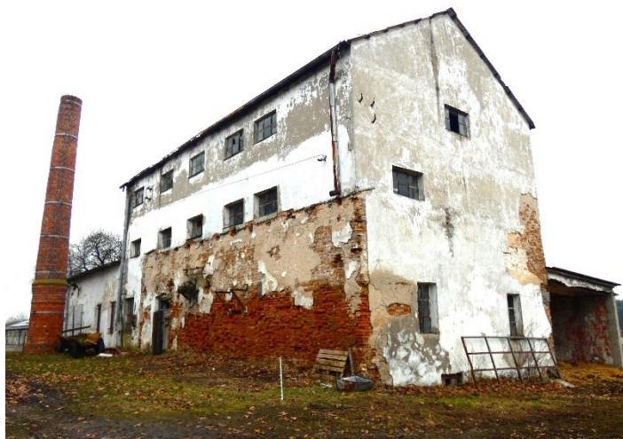
Fot. 13. Gorzelnia w Trynosach-Osiedlu
